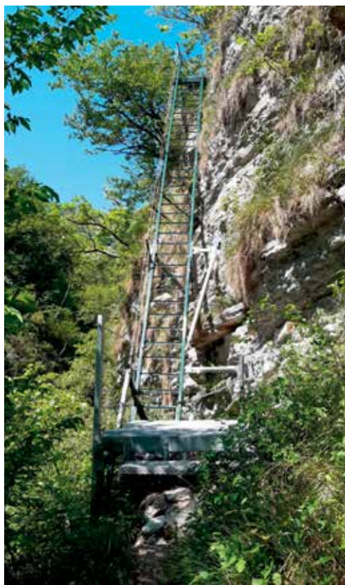
La Scala di Ferro dopo i lavori di messa in sicurezza
